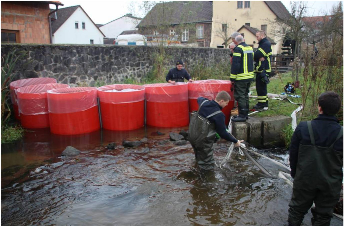
Bei den Arbeiten wird an dem Wehr, das den Zulauf zum Mühlrad regelt, der komplette Holzaufbau durch gut abgelagertes und getrocknetes Eichenholz ersetzt, dass besonders bei ständig wechselnden Pegelständen der Rodau eine hohe Widerstandsfähigkeit gegen Verrottung mitbringt und deshalb prädestiniert für diesen Einsatz ist. Das beliebte Mühlrad wird sich dann mit Abschluss der Zimmermannsarbeiten wieder nach etwa einer Woche wie gewohnt drehen.
