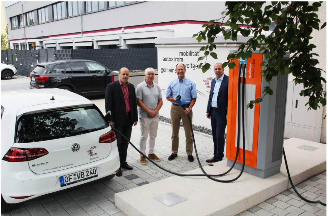
Die neue Mühlheimer Elektro-Tankstelle verfügt über drei Ladestationen – zwei mit Wechselstrom und eine mit Gleichstrom – und ermöglicht die Aufladung eines Mittelklassewagens in ca. einer halben Stunde.
