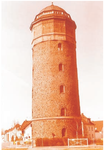
Der Wasserturm in Mühlheim.
