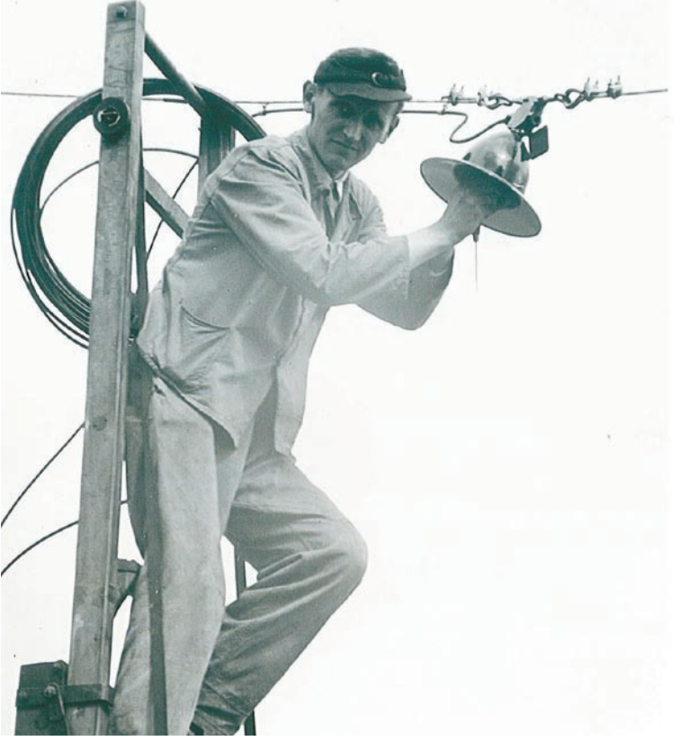
Austausch der Straßenbeleuchtung in früheren Tagen.
