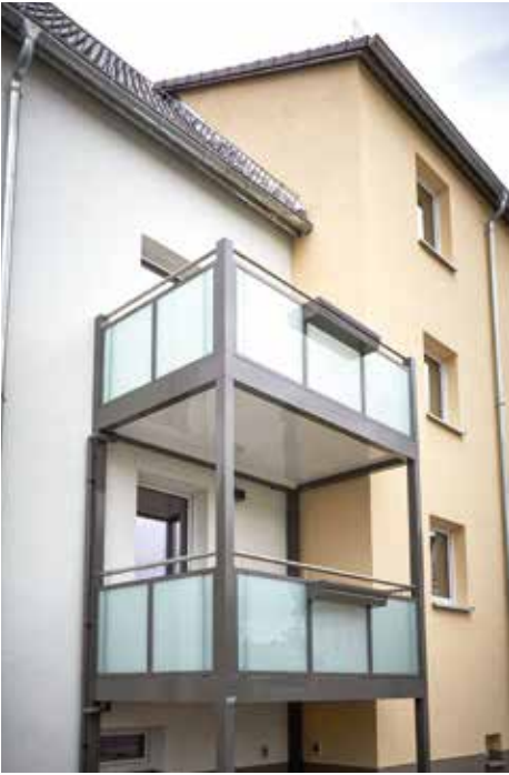
Neu angebaute Außenbalkone am Bestandsgebäude erhöhen den Wohnwert. (Bild: A. C. Lingnau)
