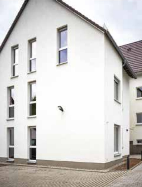
Durch den neuen Anbau mit drei 3-Zimmer-Wohnungen wird die Gesamtwohnfläche der Liegenschaft fast verdoppelt. (Bild: A. C. Lingnau)
