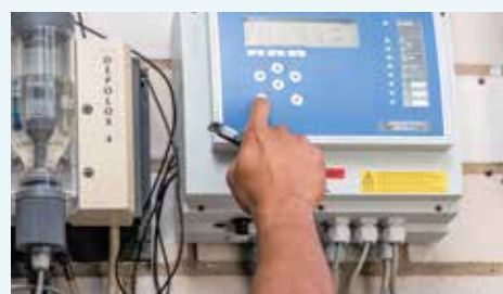
Überprüfung des Chlorgehaltes.
