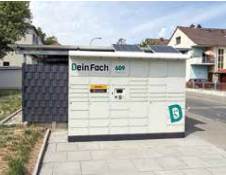
Die erste „Dein Fach“-Paketstation in der Hoffmannstraße wird von DHL und UPS beliefert, weitere Paketdienste sollen sukzessive dazukommen. (Bild: Wohnbau Mühlheim)
