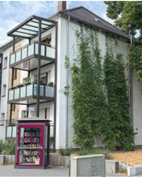
Ansprechend anzuschauen und günstig fürs Mikroklima: Stilvolle Fassadenbegrünung in der Ludwigstraße. (Bild: Wohnbau Mühlheim)
