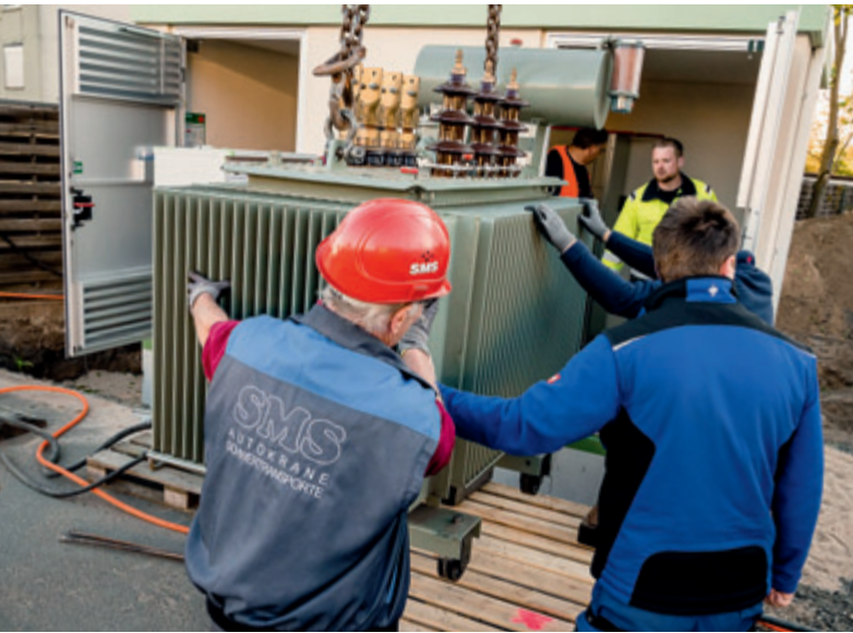
Das „Herz“ jeder Trafostation: der Transformator. Hier zu sehen beim Einbau.
