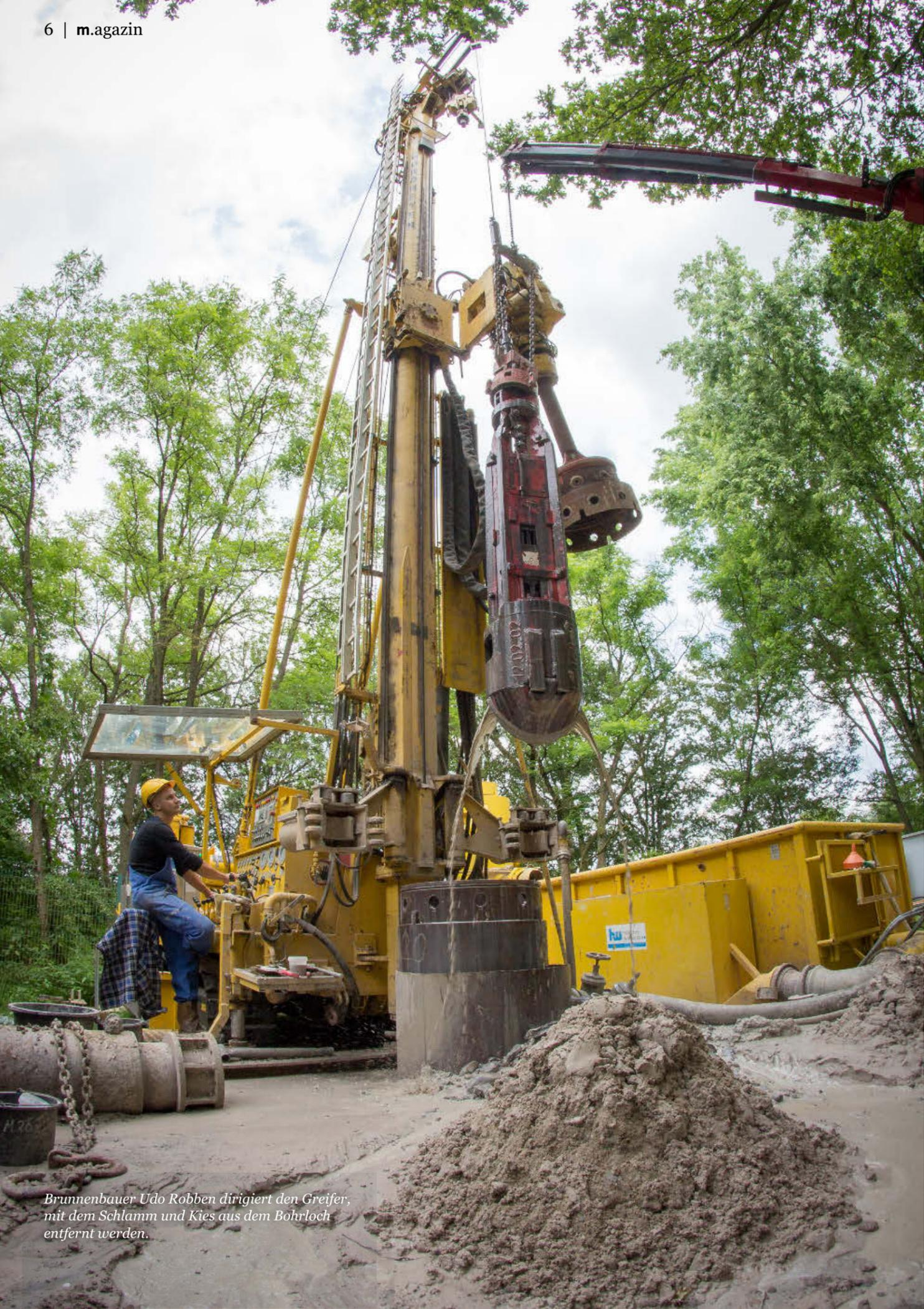
Brunnenbauer Udo Robben dirigiert den Greifer, mit dem Schlamm und Kies aus dem Bohrloch entfernt werden.
